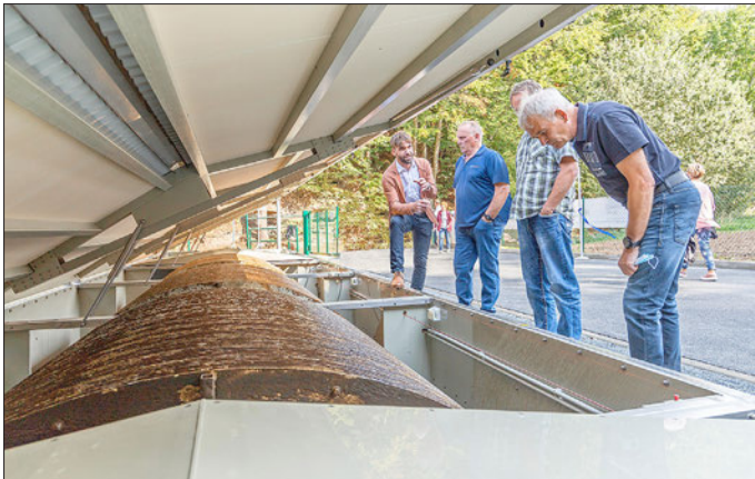
Marcus Heinemann (links), Fachbereichsleiter bei der EW Wasser, erläutert die Funktionsweise der Scheibentauchkörper der naturnahen Kläranlage Thalwenden.
