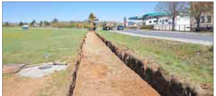
Neubau Fuß- und Radweg Heiligenstädter Straße
