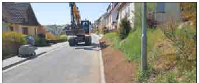
Ölbergstraße - Ortschaft Helmsdorf - letzte Arbeiten
