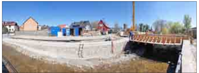
Neubau Brücke mit Uferbefestigung am Rasenweg
