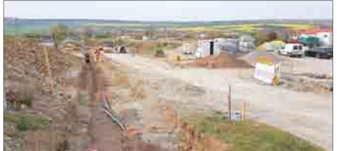
Neubau der Straße 2. BA IG „Am Rode“
