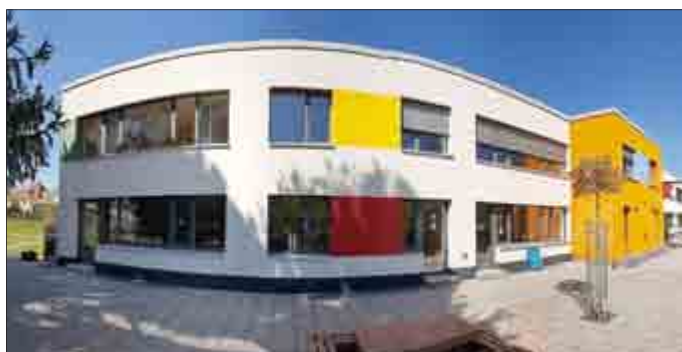
Fertigstellung Außenanstrich an der Rückseite der KITA - Bummi
