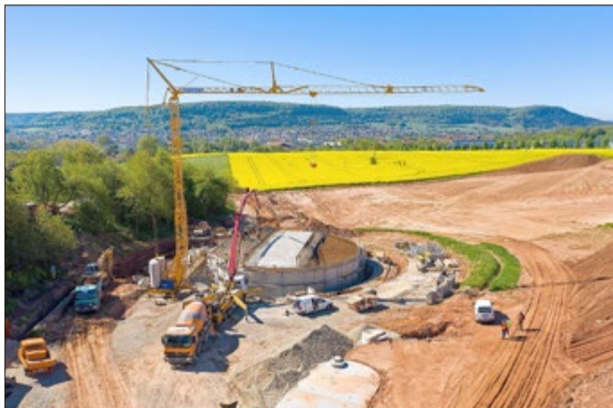
Mit großem Gerät und Man-Power wurde die Decke des Hochbehälters im Gewerbegebiet „An der A38 - Ost“ gegossen.
