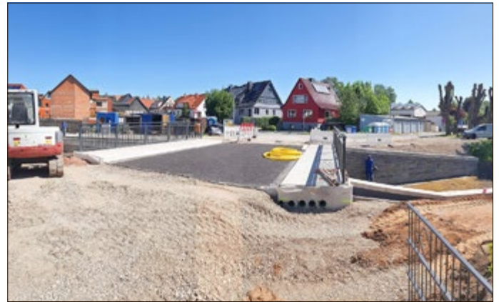
Brücke über die Unstrut – Rasenweg, Fertigstellung des Brückenasphalts, Kappenbetons, und des Geländers
