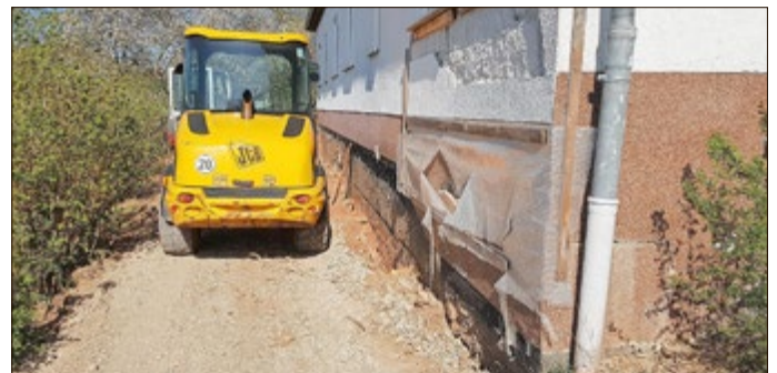
Bauarbeiten am Sportlerhaus Kefferhausen - Hier beteiligt sich die Stadt Dingelstädt im Rahmen der Sportstättenförderung an der Fundamentunterfangung für das Gebäude.
