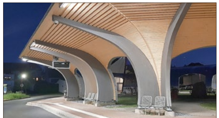
Beleuchtungsprobe am Busbahnhof
