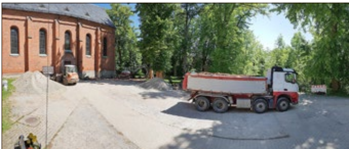
Beginn der Bauarbeiten am Kerbschen Berg
