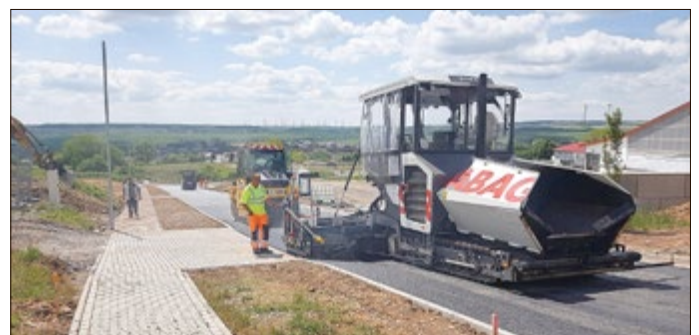
IG Am Rode - Asphaltarbeiten wurden am 25.05.2020 abgeschlossen. Die Baumaßnahme steht kurz vor ihrer Fertigstellung.
