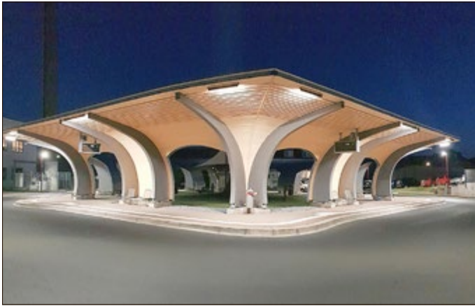
Beleuchtungsprobe am Busbahnhof
