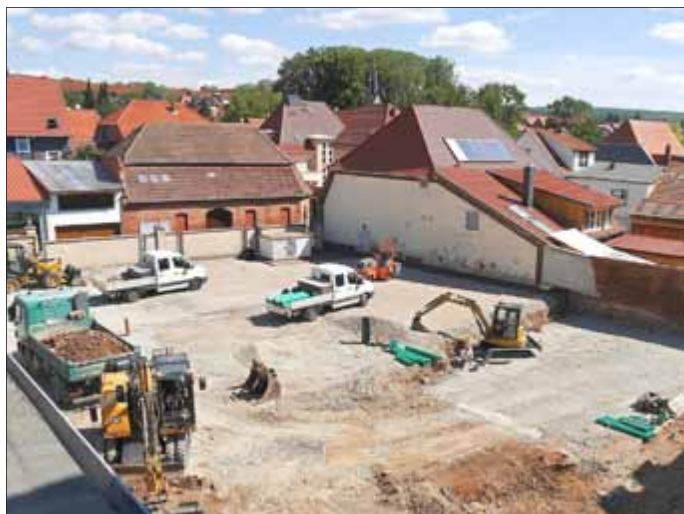
Stand der Bauarbeiten am 09.08.2018
