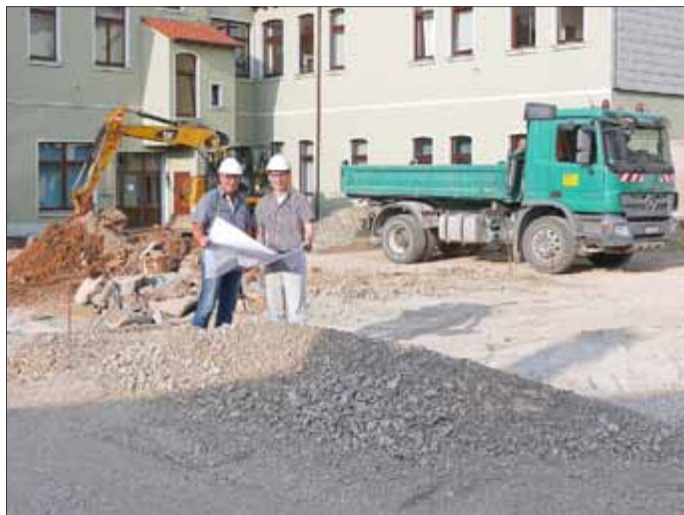
Bauberatung links Raimund Nachtwey (Bauamt) und Bürgermeister Andreas Fernkorn
