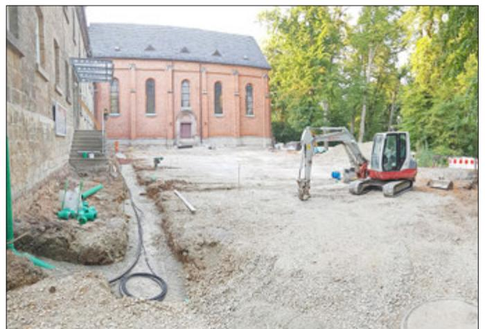
*Kerbscher Berg - Verlegung der Kanal- und Kabelleitungen*
