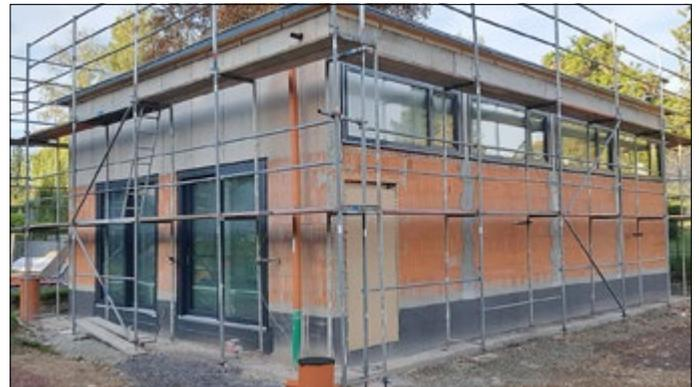
*Die Fenster der neuen Turnhalle sind eingebaut. Das Gerüst für den Außenputz steht.*
