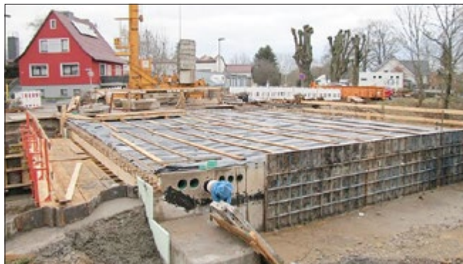
Unstrutbrücke - Rasenweg 02/2020 in der OS Dingelstädt
